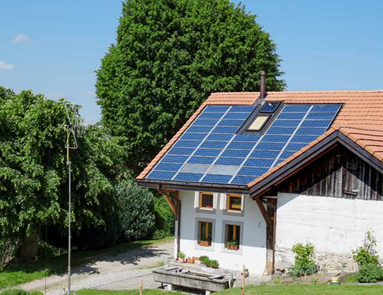
■ L'OFCOM mesure les interférences électromagnétiques des installations photovoltaïques.
