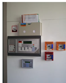
Kennzeichnung und Dokumentation gemäss NIN
