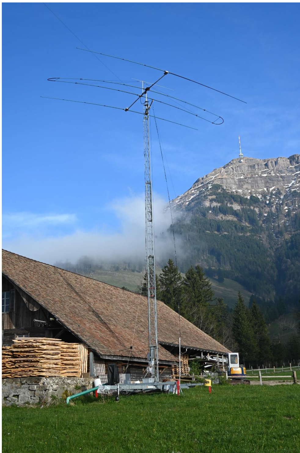
Antenne bei HB9ZG, StepIR, G5RV
