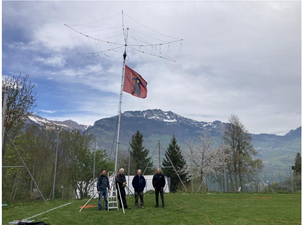
Nun fehlen nur noch die Abspannungen.
