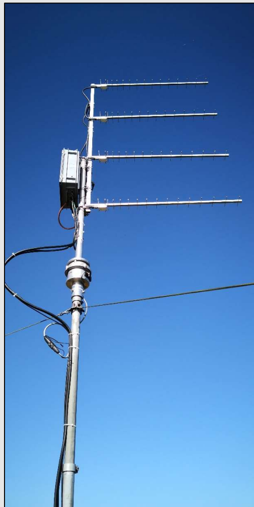
HB9XC – QTH JN37MD (BE) – 4x16ele für 1296 MHz
