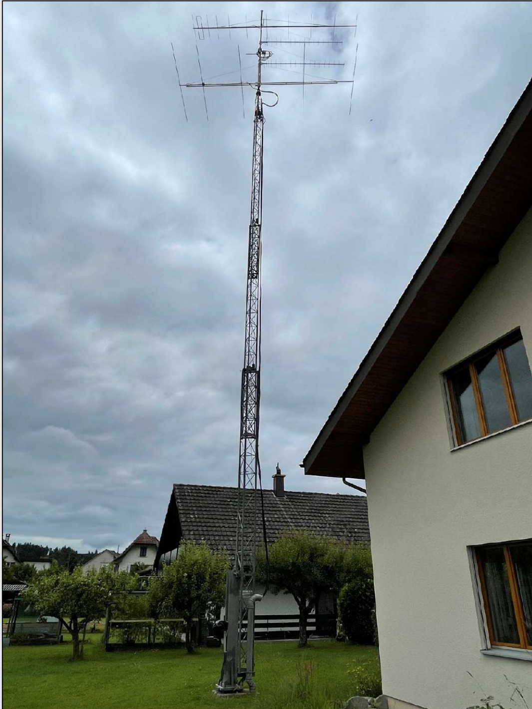
HB9TTY– JN37XG (AG) – 5ele für 50 MHz
